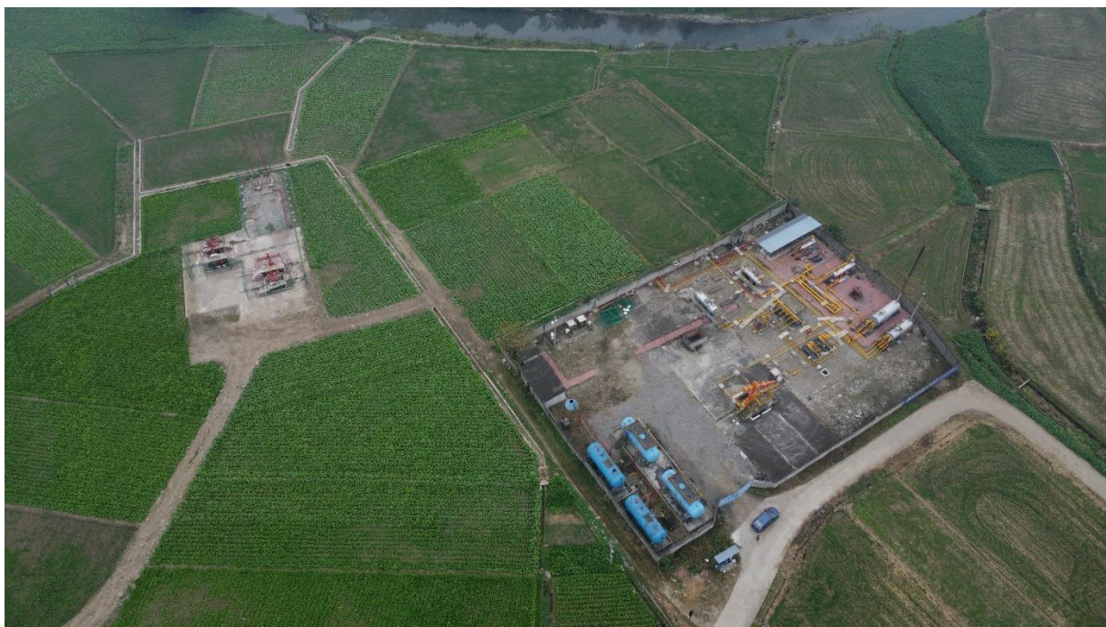
图 5.1-1 项目临时占地恢复情况
